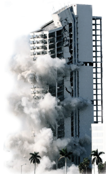
Destruction de bâtiments
