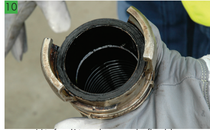
Vérifier l'état du joint du flexible
