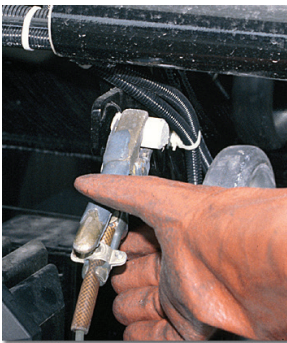
Mise à la terre
