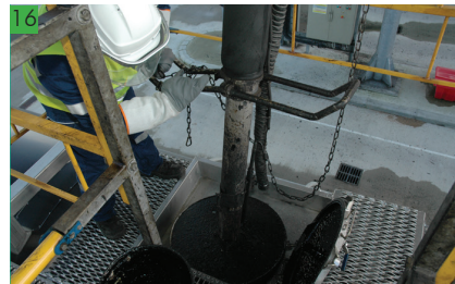
Mise en place du bras de chargement
