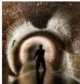
Assainissement et traitement de l'eau
